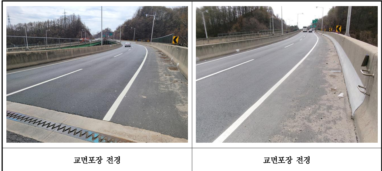
【사진 1.3.17】 교면포장 전경
