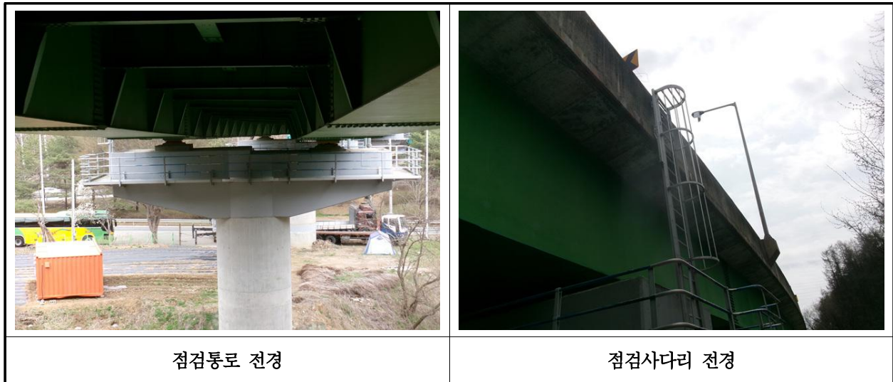
【사진 1.3.23】 교량 점검시설 전경
