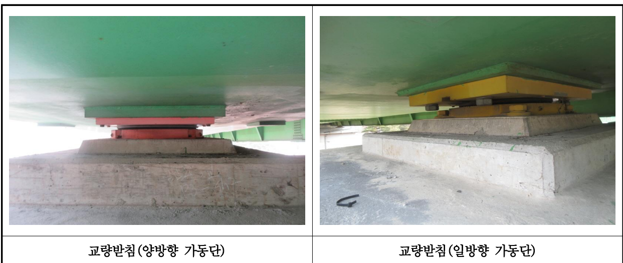
【사진 1.3.13】 교량받침 전경
