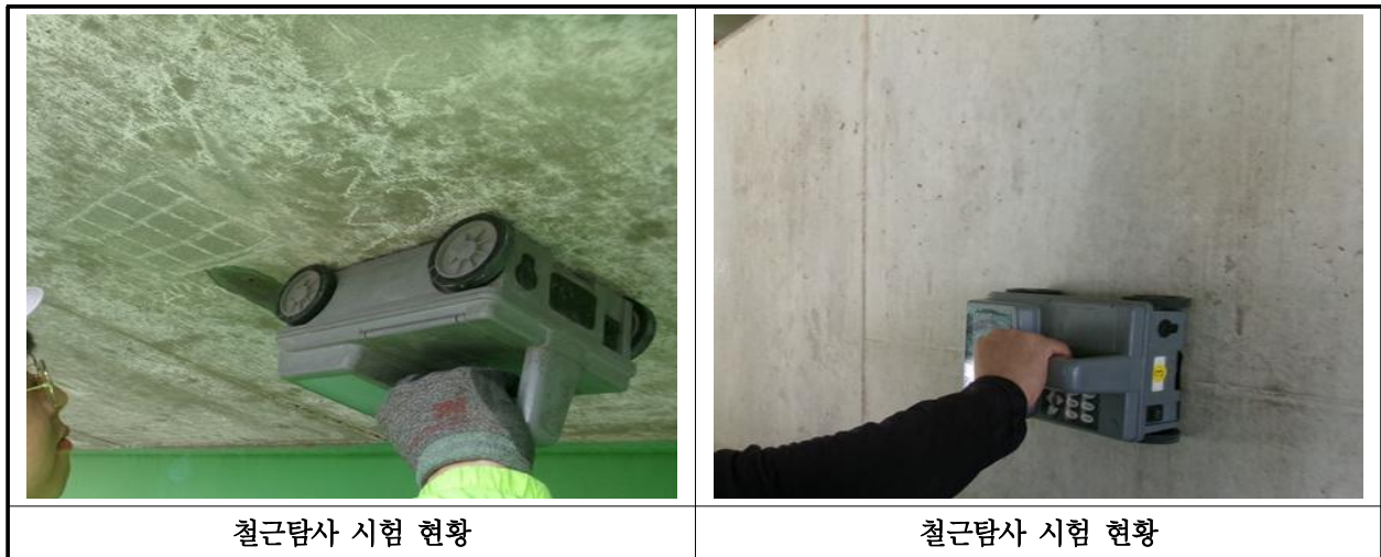
【사진 1.4.2】 철근탐사 시험
