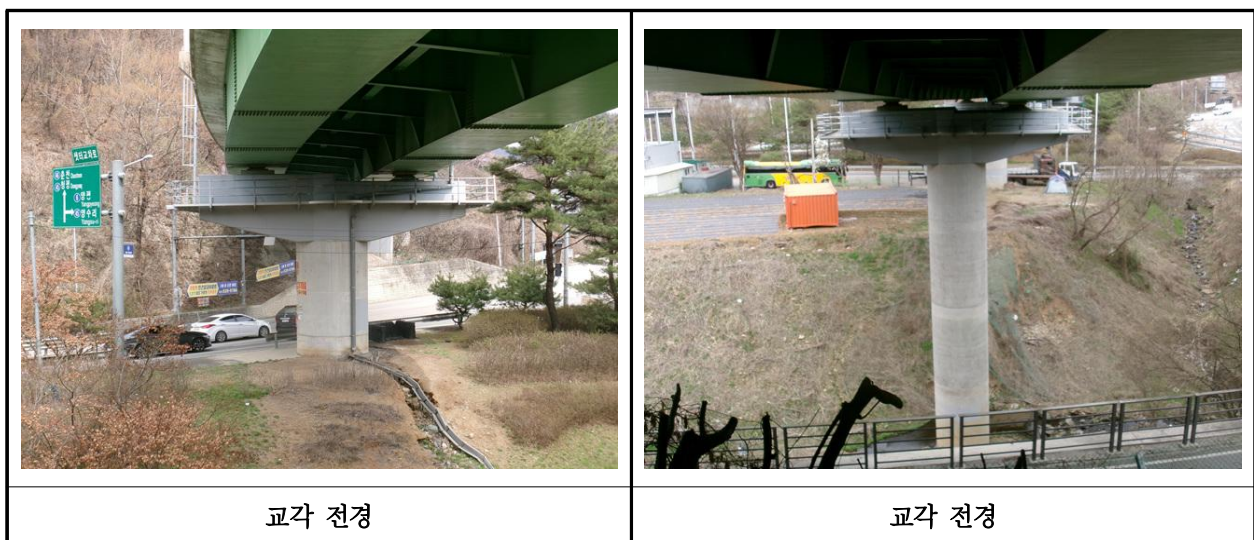
【사진 1.3.11】 교각 전경
