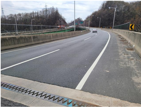
교량 상부 전경
