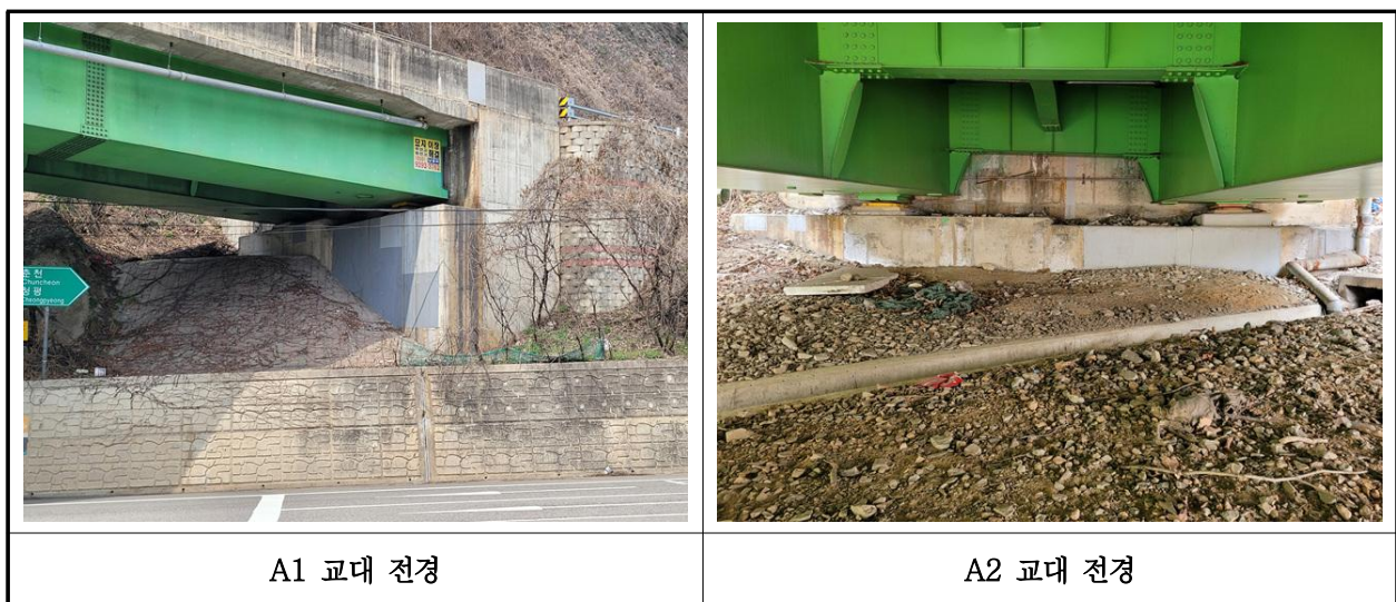
【사진 1.3.9】 교대 전경
